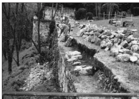
Démontage du haut du mur
