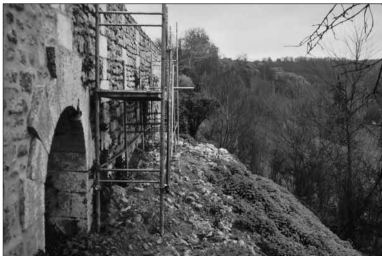
Reconstruction et consolidation du mur
