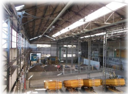
Installation de fabrication des mélanges
