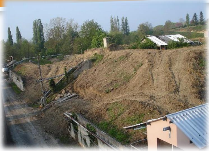
1/ Enlèvement des terres de recouvrement
