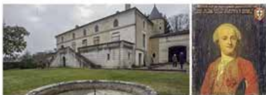
Chalonne, rénové par le Marquis de Montalembert
