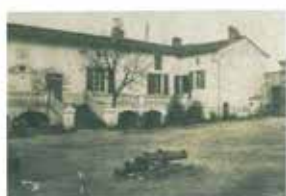
La Vergne, XVIIIe ( chais sous la terrasse )
