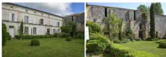
En limite de commune, le logis de Moulède et sa chapelle du XIII e
